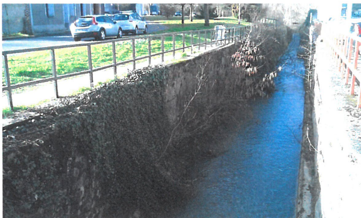
Suppression du mur rive gauche
