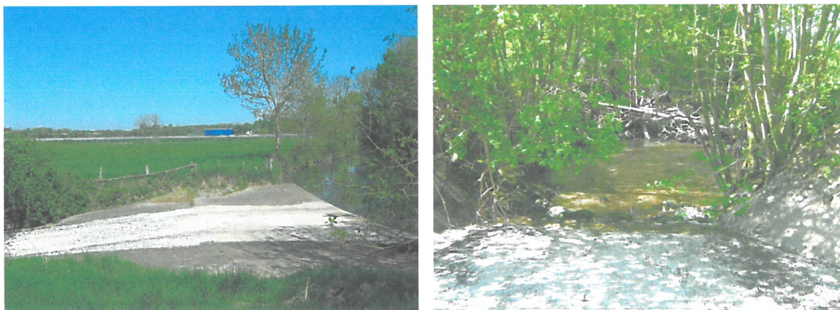
Photo du déversoir d'orage à gauche et de l'aval de l'ouvrage à droite.
